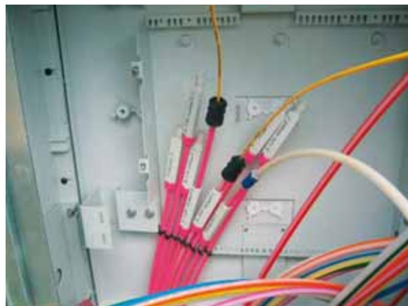
Der nächste Montageschritt. Die Adressen „Dr.-Viktor-Waldner-Str. 3 und 4“ sind bereits mit Glasfaserkabeln angeschlossen. In die speed•pipe®-ground zu „Berglandstraße 2“ wird gerade das Minikabel eingeblasen. Das KmR bleibt auf der speed•pipe®-ground.
