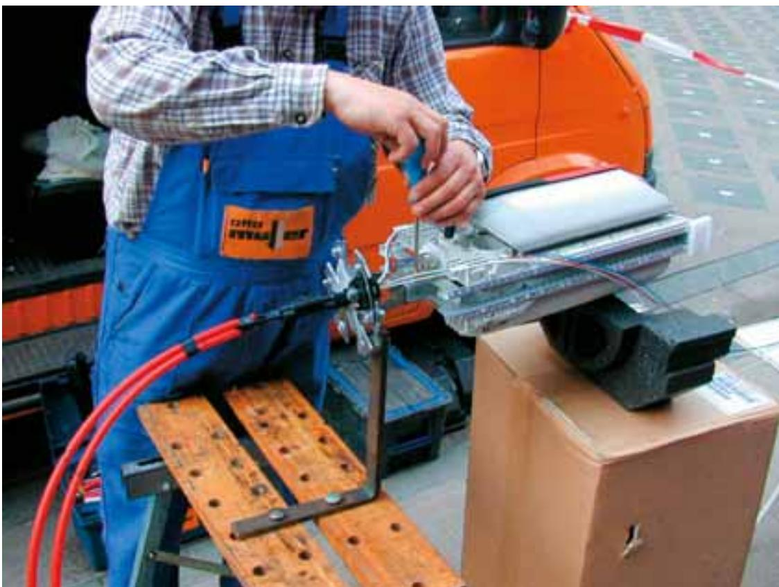
Montage der Minikabel in der Gel-Muffe außerhalb des Schachtes.
