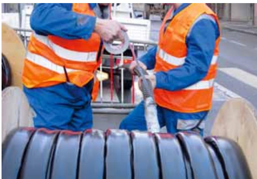
Kabelziehstrumpf auf SRV 50/8 x 10 aufbringen und Ende abkleben.
