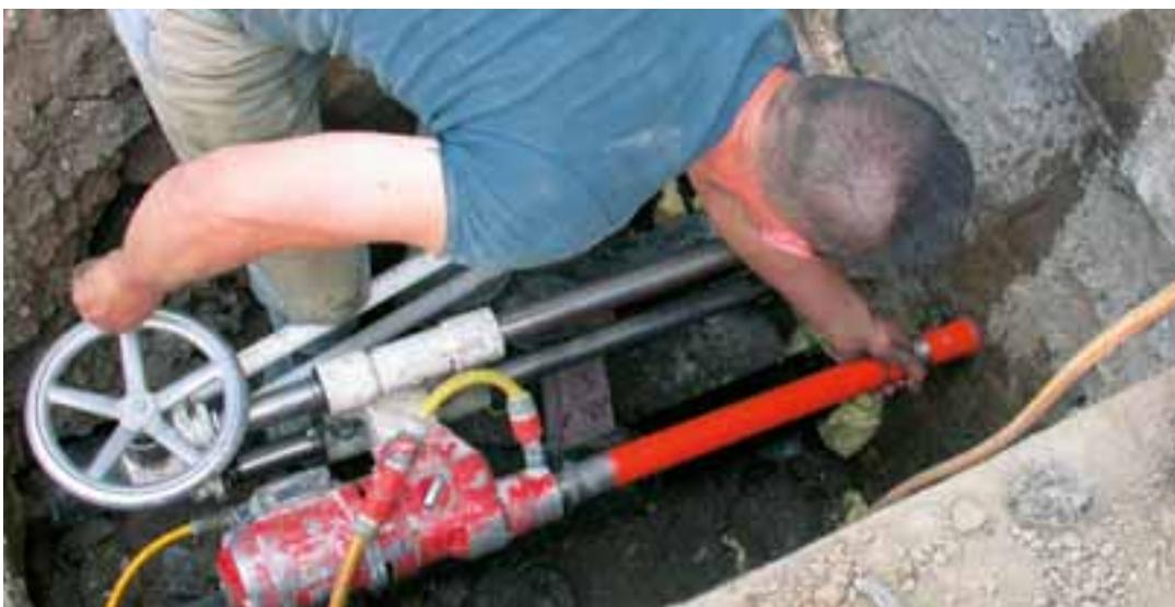
Kernbohrung in der Betonwand / core drilling in concrete wall / carottage dans le mur béton / Ø 47 mm
