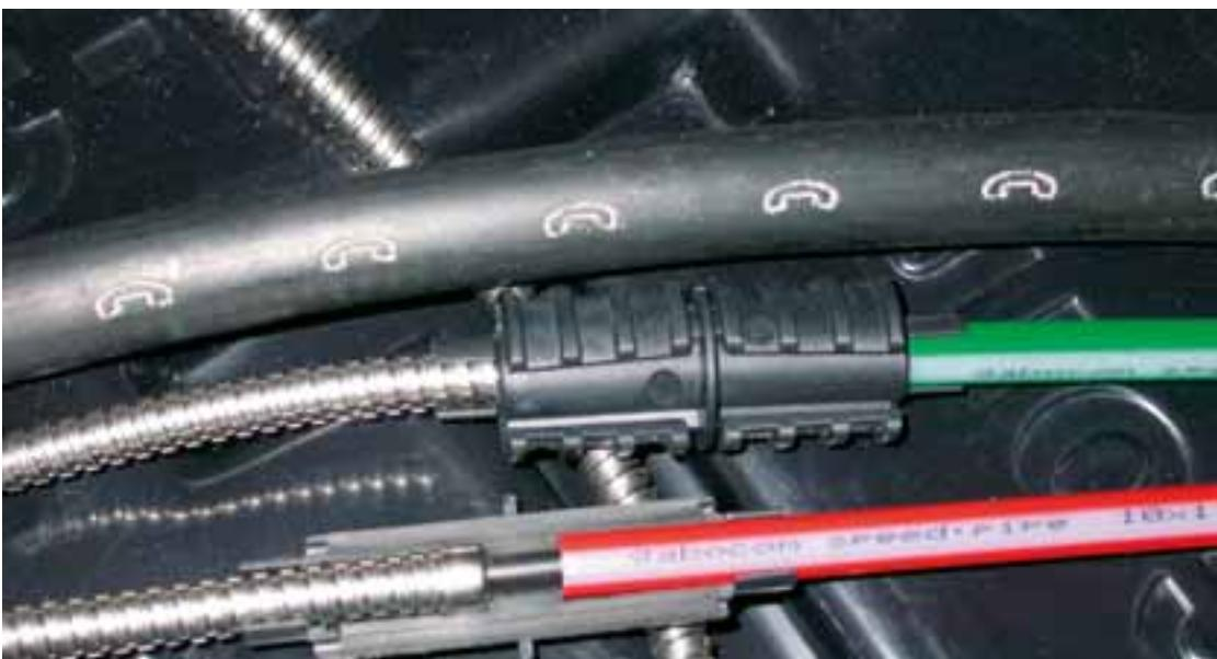
Verbindung von gabocom-speedpipe® mit V2A-Wellrohr durch EBM-GS (gabocom-EinBlasMuffe-Gas-Stop). Gas- und wasserdicht auch in Längsrichtung.
