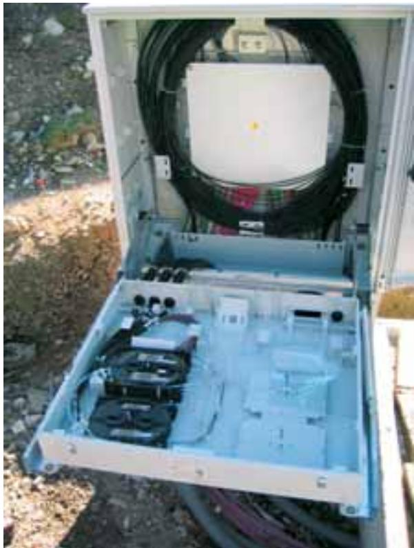
Das Spleißen von Minikabeln von 72 (60) Fasern auf Hausanschluß-Kabel mit 4 (bis 24) Fasern erfolgt zum Beispiel in einem KabelVerzweigerKasten (KVZ) oder einem Abzweigkasten (AZK).
