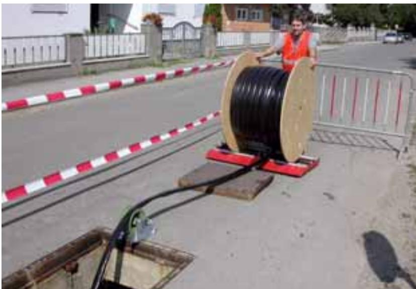
Das Abspulen des Rohrverbandes von der handlichen Spule ( $\varnothing 1200 \times 700$ ) mit 300 m.
