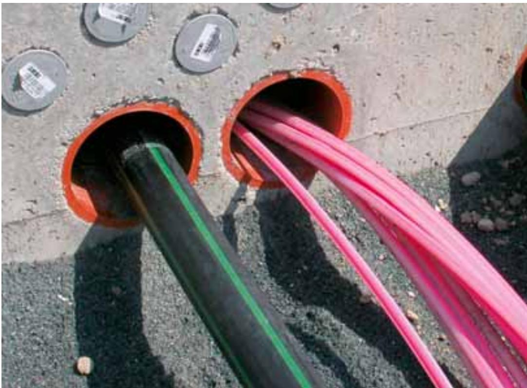
Die gabocom-speed●pipe®-ground 10 x 2 erdverlegt wie ein PEHD-Rohr 50 x 4,6.
