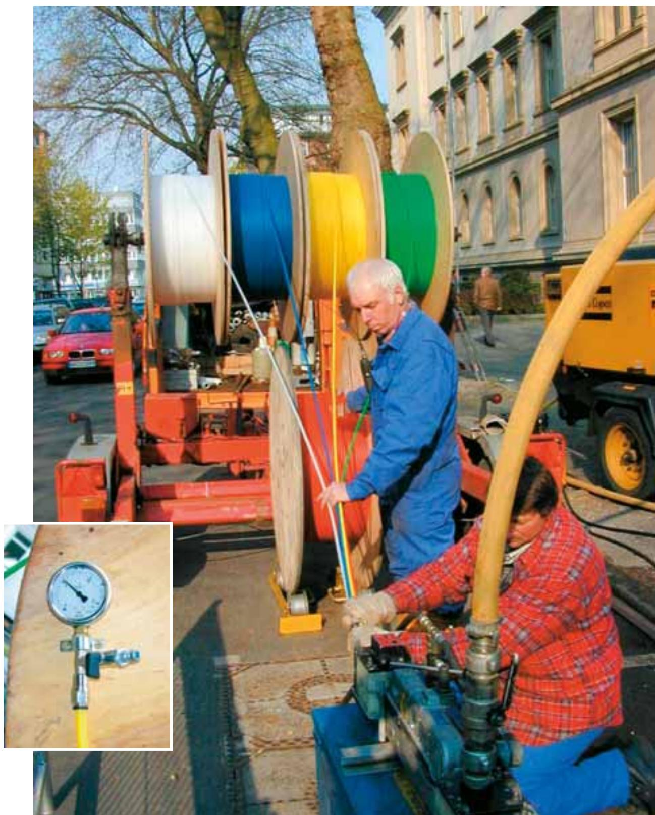
gabocom-speed•pipe® werden direkt von der 2.500-m-Spule mit dem super jet in das noch freie Kabelrohr der Deutschen Telekom geblasen. Zur Versteifung der speed•pipe® werden diese während des Einblasens auf einem Innendruck zwischen 5 und 10 bar gehalten.
