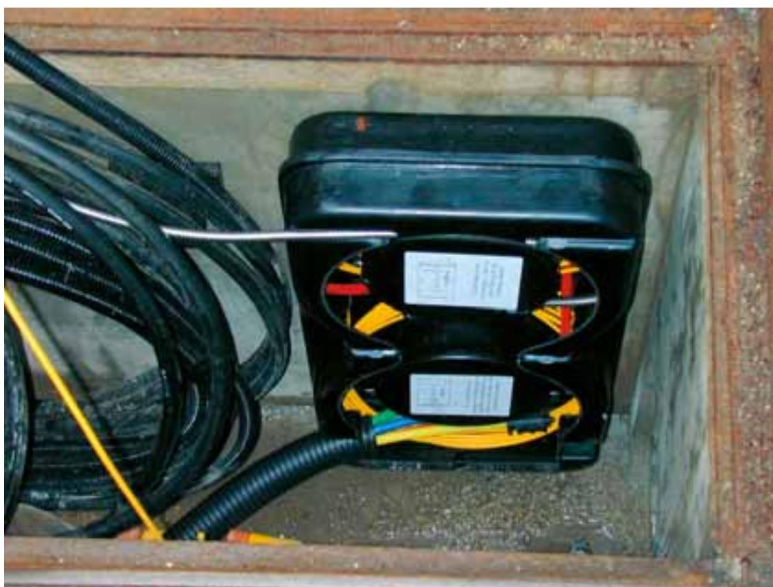
**Abdichtelement mit Schutzbogen für die Hauseinführung / Sealing element with protecting bend for house entrance / Élément d'étanchéité avec coude de protection pour le raccordement d'immeuble / ADSB / ADSB-D**
