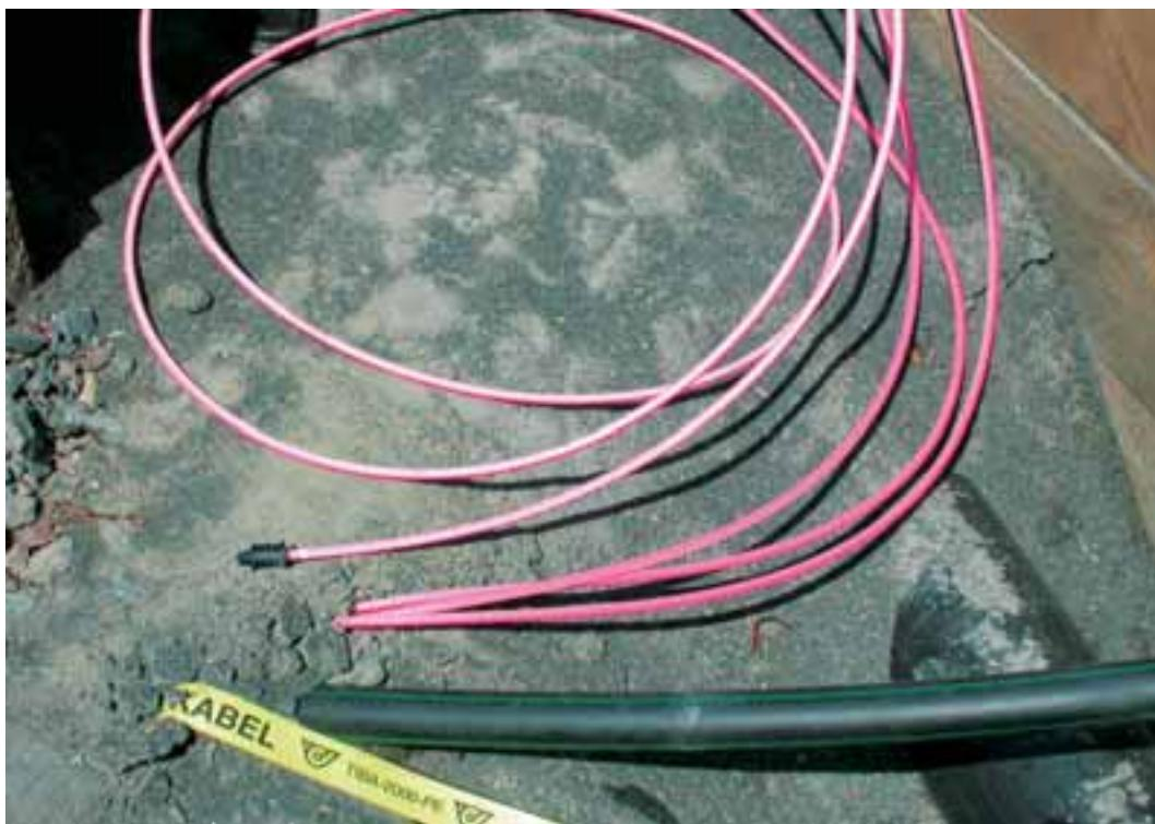
Die freien Enden der gabocom-speed•pipe®-ground sind schon während der Montage gas-, wasser- und schmutzdicht verschlossen.
