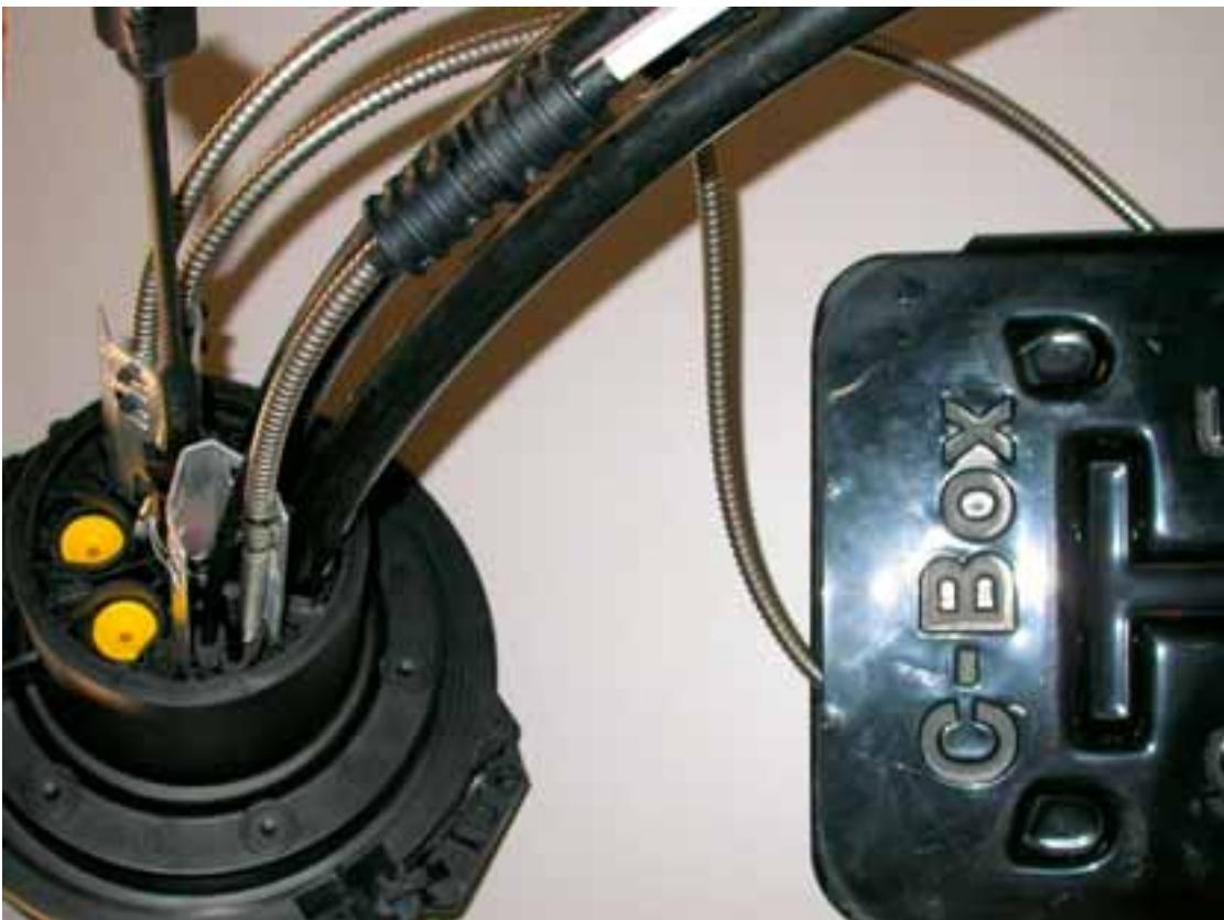
Sicherheit für den Anschluß des Minikabels an der Muffe. Befestigen des V2A-Wellrohres mit Minikabel am Muffeneingang.
