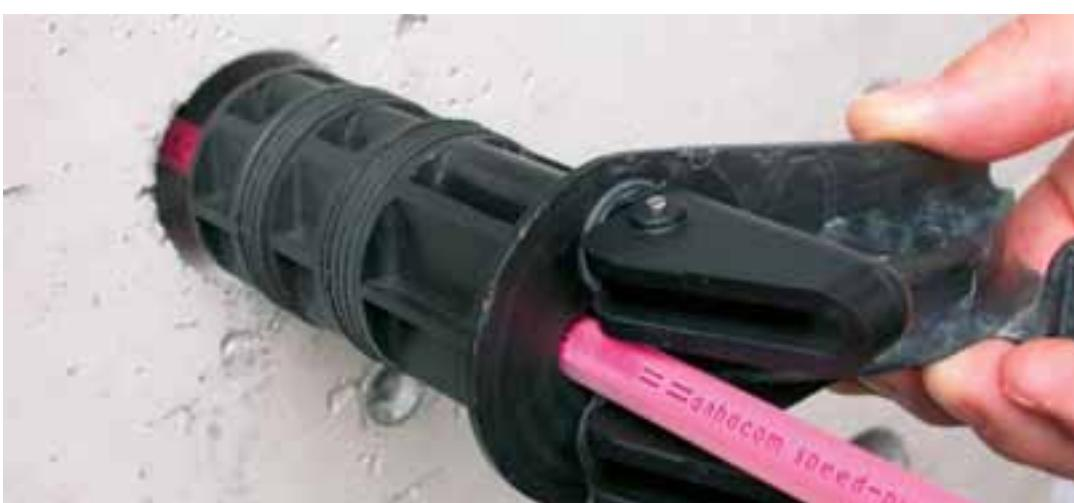
Abdichten auf der Haus-Innenseite mit dem Abdichtelement mit Schutzbogen / Sealing from inner side of house with / Etanchéité à l'intérieur de l'immeuble grâce à l'élément d'étanchéité avec coude de protection – ADSB 9-12,5
