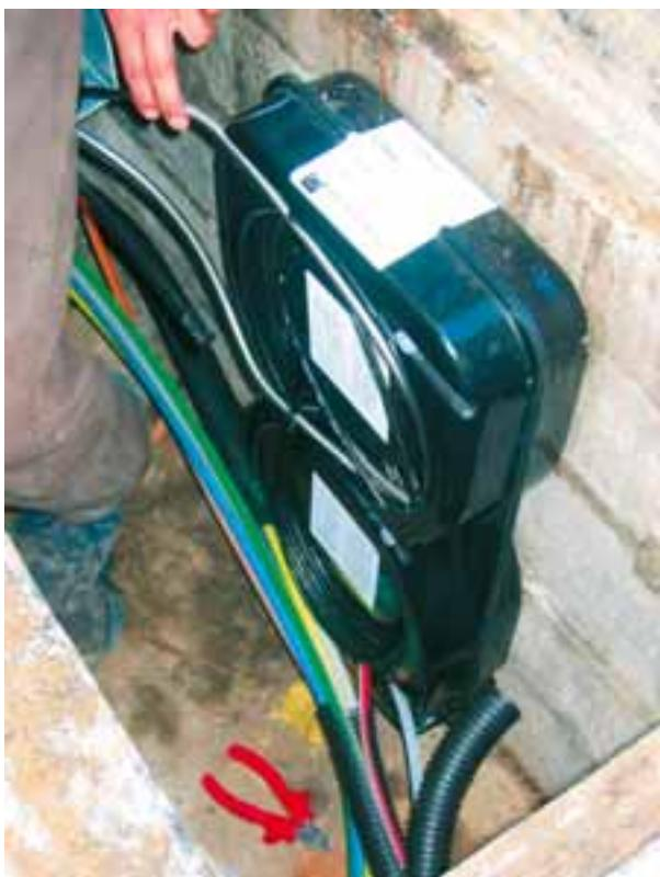
Minikabel auf dem Weg zwischen Cable-Box und Muffe mit 10 mm V2A-Wellrohr schützen.
